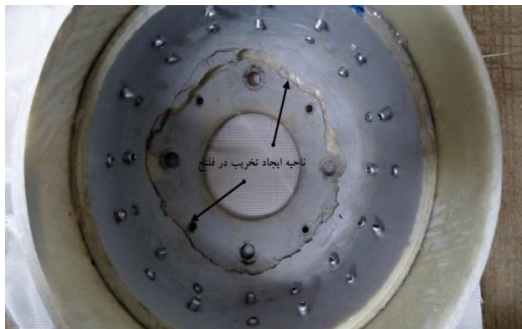
شکل ۱۹- ناحیه‌ی ایجاد شکست در فلنچ شماره ۲
