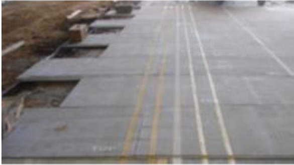
شکل ۱- نمایی از صفحات AM-2 ترمیم‌کننده باند فرودگاه
