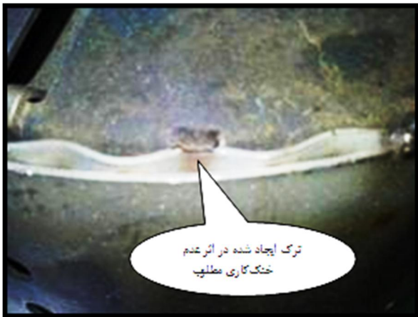
شکل 16- نمونه واقعی ترک ایجاد شده در اثر عدم خنک‌کاری مطلوب
